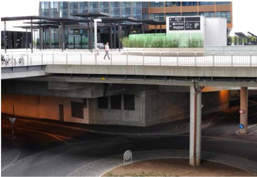
Il. 5. W założeniu Donau-City zastosowano zasadę segregacji ruchu pieszego i kołowego (fot. Katarzyna Zawada-Pęgiel, stan z roku 2015).
