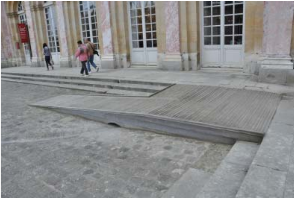
Il. 7. Drewniana rampa – nakładka na historyczne schody, fot. D. Sikora, 2016.
