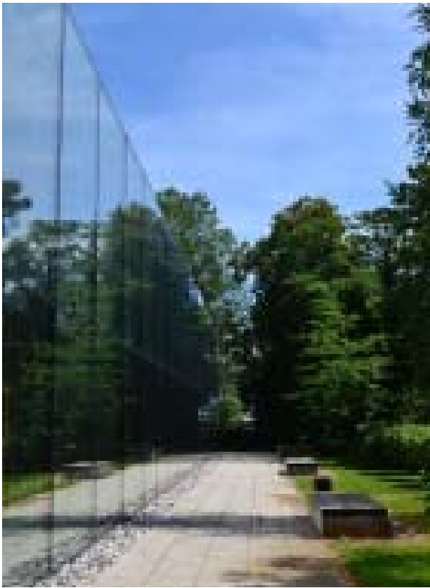
Il. 2. Budynek sali wielofunkcyjnej z kawiarnią. Fot. A. Tarnawska.
