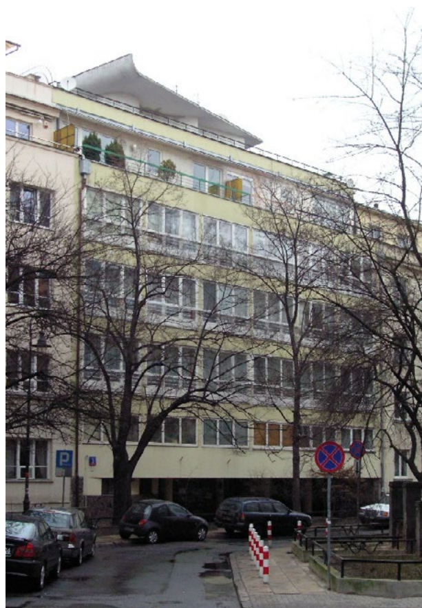
Il. Dom mieszkalny, Warszawa, al. Przyjaciół 3, proj. Juliusz Żórawski, 1935–1937. Fot. J.K. Lenartowicz 2010
