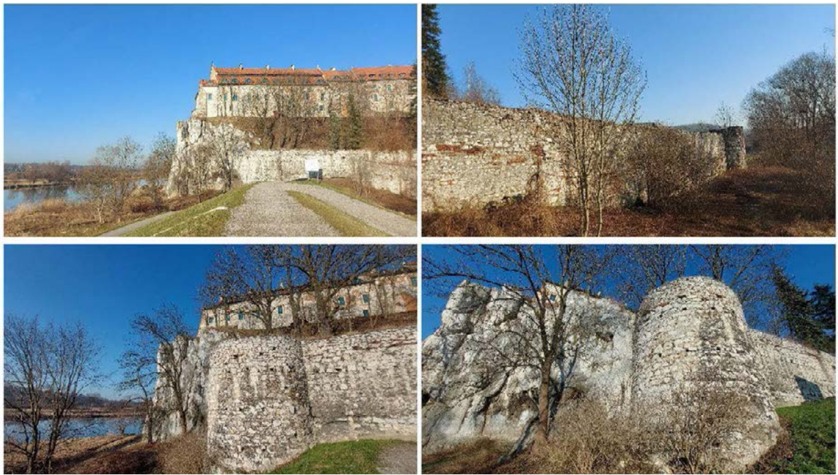
III. 3. Traces of the fortifications of the tower system (defensive walls with arrowslits, tower). Original photo (January 2024) II. 3. Ślady fortyfikacji systemu basztowego (mury obronne ze strzelnicami, baszta). Fot. Autorka (styczeń, 2024).
