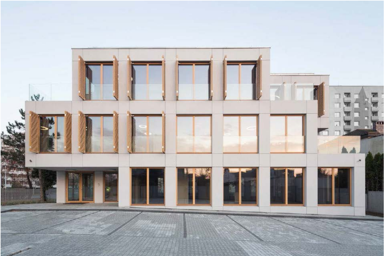
III. 3. EXG office building, Częstochowa, design by OVO Grąbczewski Architekci. Photo by T. Zakrzewski II. 3. Budynek biurowy EXG, Częstochowa, proj. OVO Grąbczewski Architekci. Fot. T. Zakrzewski.
